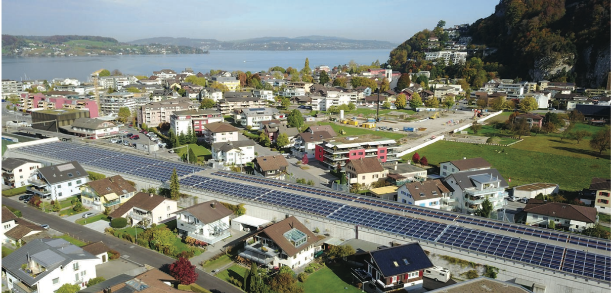
Abbildung 9: 750 MW-Anlage auf der Autobahnüberdachung in Stansstad. Foto: Schweizer Solarpreis 2018.
