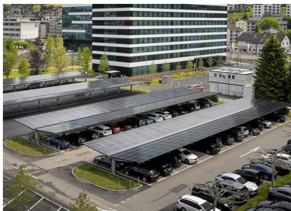
Abbildung 8: Der Carport der Schindler AG schützt die Autos vor der Witterung und produziert gleichzeitig 310 MWh. Foto: Schweizer Solarpreis 2020.
