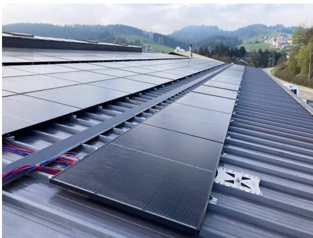
Abbildung 4: Befestigung auf Trapezblech Fotos: Genossenschaft Solar St. Gallen
