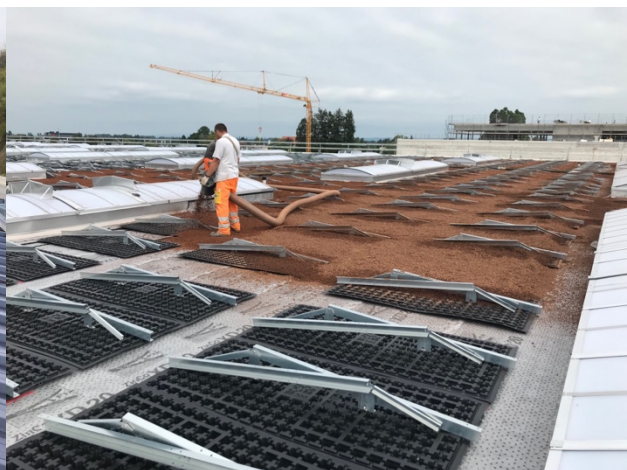
Abbildung 3: Gründach-PV-Unterkonstruktion wird mit Substrat beschwert
