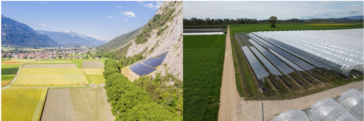
Abbildung 11: Die Calinis-PV-Anlage im ehemaligen Steinbruch in Felsberg/GR produziert 1.6 GWh pro Jahr. Foto: Schweizer Soalpreis 2021.
