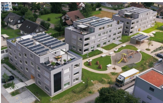
Abbildung 5: Teilweise Nutzung der Fassade mit einer integrierten PVA. Foto: Schweizer Solarpreis
