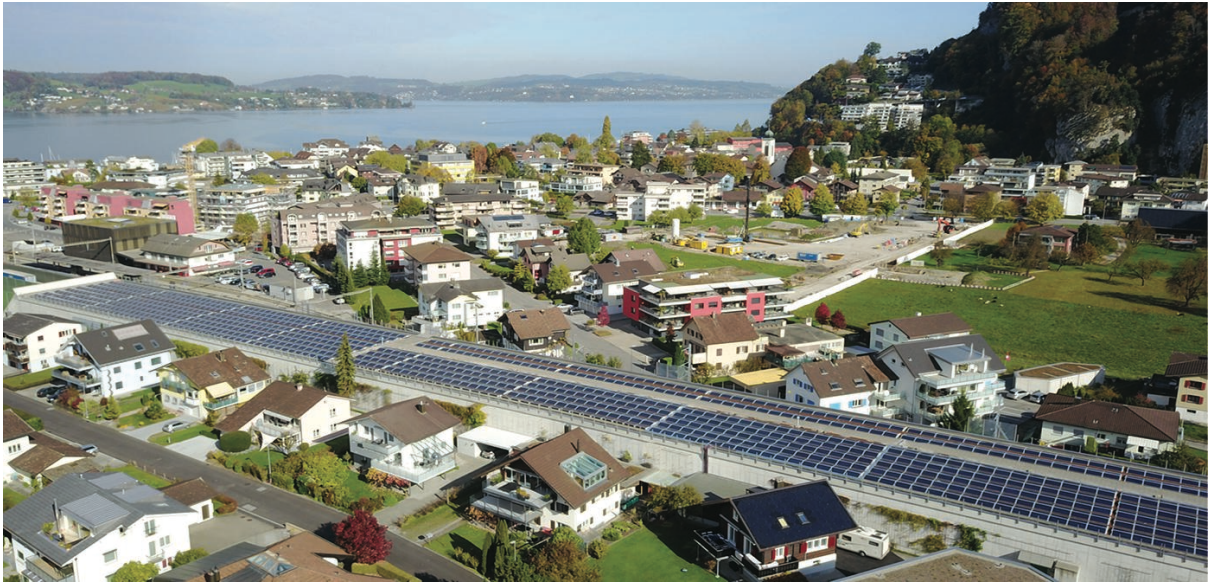
Illustration 5 : Installation de 750 MW sur le toit de l'autoroute à Stansstad. Photo : Prix solaire suisse 2018.
