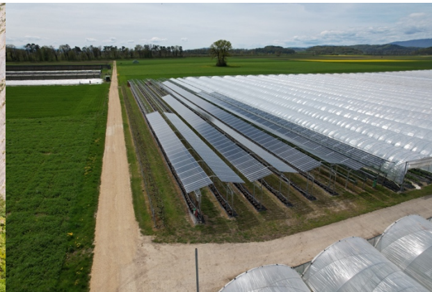
Figure 7 : La centrale de 167 kW de Beerenland à Walperswil, qui n'est pas encore terminée sur la photo, produit de l'électricité tout en favorisant la culture des fraises. Photo : Beerenland AG.
