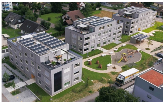
Figure 5 : Utilisation partielle de la façade avec un PVA intégré. Photo : Prix solaire suisse 2020.
