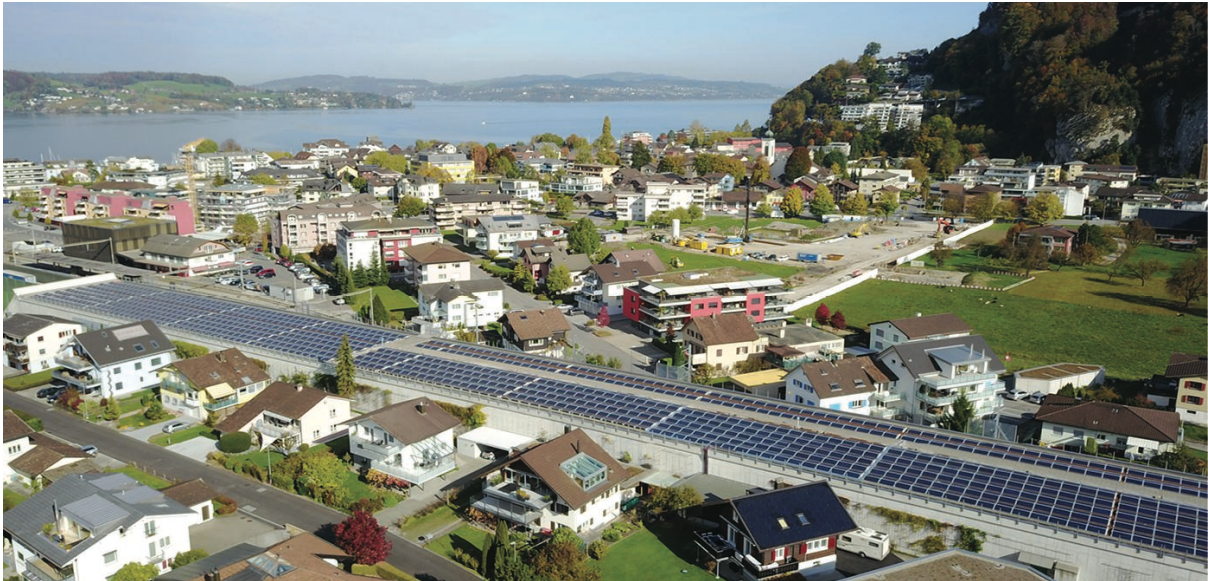
Illustration 5 : Installation de 750 MW sur le toit de l'autoroute à Stansstad. Photo : Prix solaire suisse 2018.
