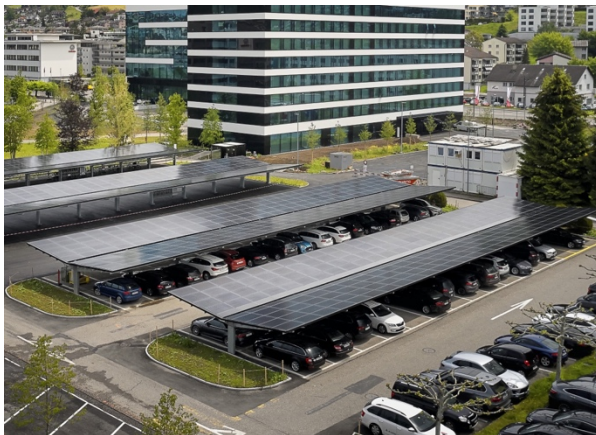
Illustration 3 : Le carport de Schindler AG protège les voitures des intempéries tout en produisant 310 MWh. Photo : Prix solaire suisse 2020.
