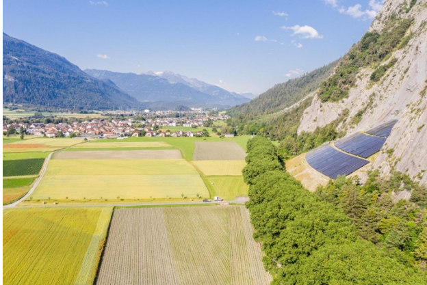
Figure 6 : L'installation PV de Calinis dans l'ancienne carrière de Felsberg/GR produit 1,6 GWh par an. Photo : Prix suisse du Soalr 2021.
