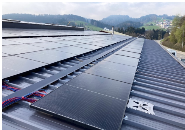
Illustration 3 : Fixation sur tôle trapézoïdale Photos : Coopérative Solar St. Gallen
