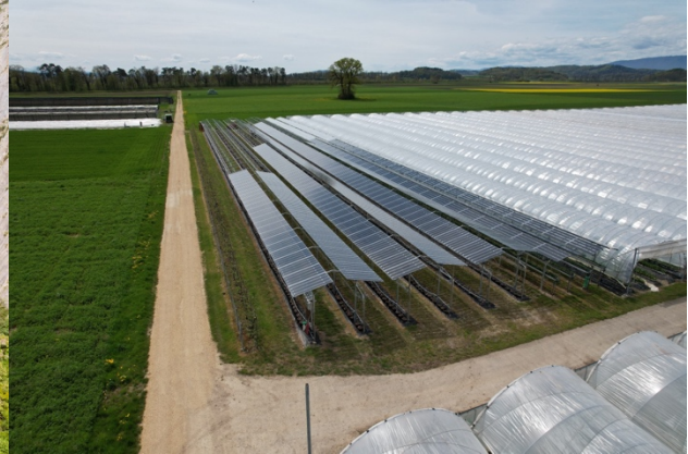
Figure 7 : La centrale de 167 kW de Beerenland à Walperswil, qui n'est pas encore terminée sur la photo, produit de l'électricité tout en favorisant la culture des fraises. Photo : Beerenland AG.
