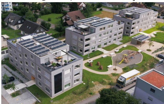
Figure 5 : Utilisation partielle de la façade avec un PVA intégré. Photo : Prix solaire suisse 2020.
